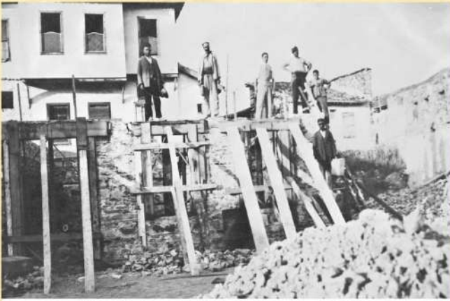
Alkış ailesine ait evin yapım aşaması 1935'ler
